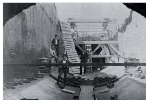
Construcción de uno de los desagües cloacales de la Ciudad de Buenos Aires.
