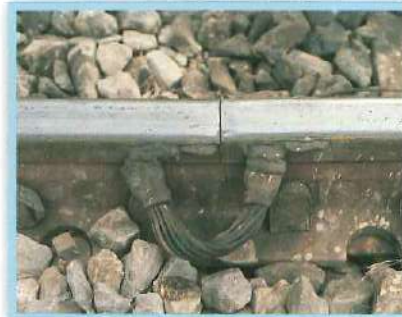
Junta de dilatación en las vías de tren.
