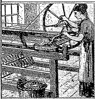
La máquina de hilar Hargreaves permitió acortar los tiempos de producción, al trabajar con varias bobinas a la vez. ¿Qué beneficio tenía esto?
