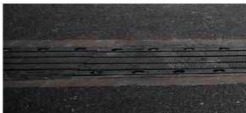
En rieles y rutas, se dejan juntas de dilatación para permitir la deformación de los materiales a altas temperaturas, sin que se produzcan rupturas.
