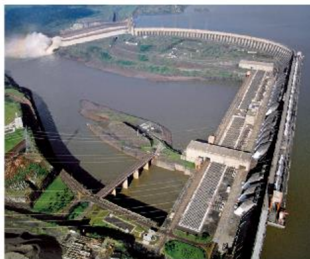
► Itaipú se construyó sobre el río Paraná, aprovechando los antiguos saltos del Guairá que el río formaba naturalmente. Esta represa tiene veinte turbinas generadoras y provee la mayor parte de la energía que se consume en Paraguay.
