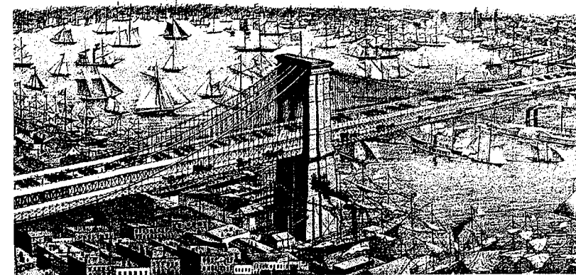
Vista del puente de Brooklyn, en la ciudad de Nueva York. Con una longitud de 490 metros, era más largo que cualquier otro puente construido hasta entonces. Los cables de acero de los que estaba suspendido demostraron la enorme resistencia de ese material.
